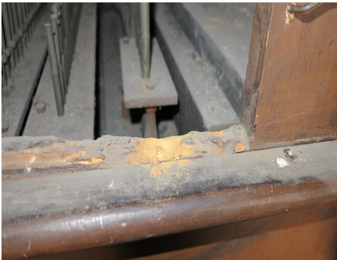
Masivní výskyt dřevního prachu požerků od dřevokazného hmyzu. Foto: Vít Honys
