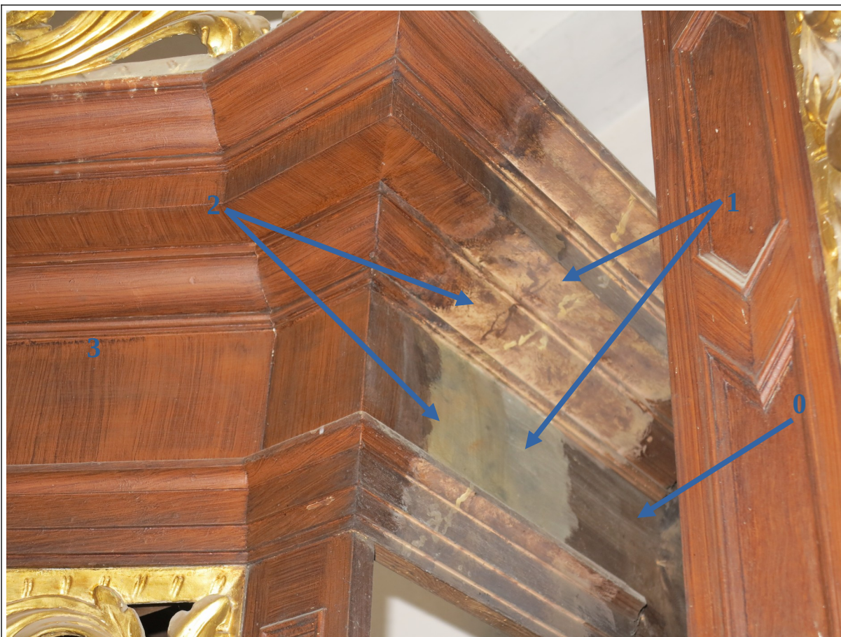
Situace v sondě A1, bok píšťalového travé: 0 – dřevo, 1 – malovaná mramorová struktura v šedo-modrých a růžovo-bílých tónech, 2 – zežloutlá konzervační vrstva, 3 – současná fládrovaná úprava. Foto: Vít Honys
