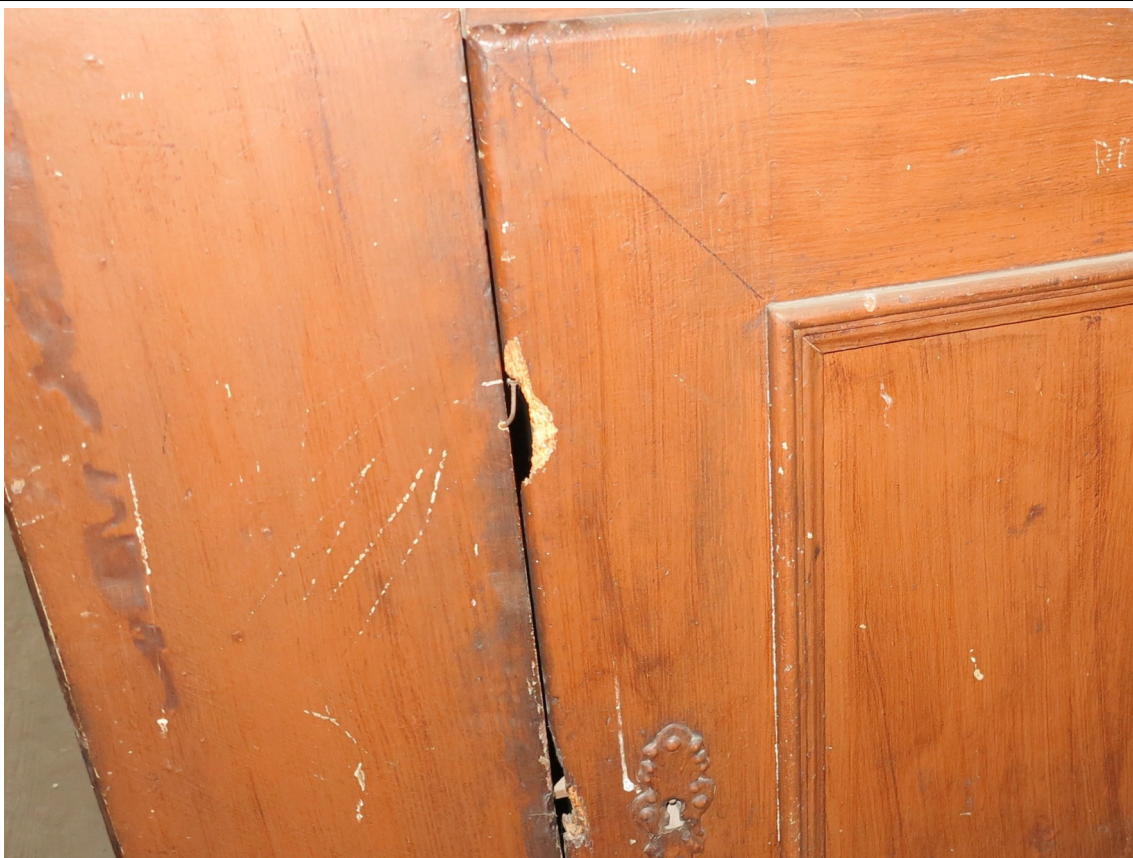
Bok postamentu v celku a detailu. Patrné větší defekty. Škrábance, otěry, vylomené hrany, potřísnění barvou, grafity. Foto: Vít Honys
